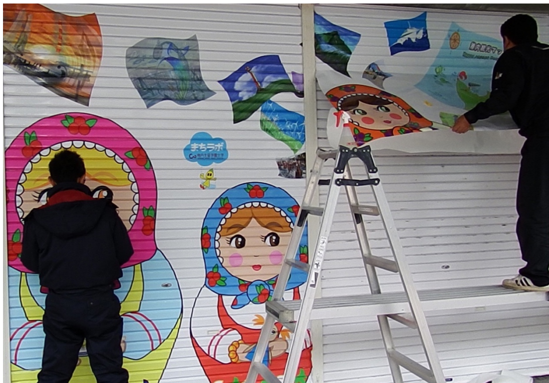
図 22 ラッピングフィルム貼り付け作業 協力 (有) 北都工芸社
